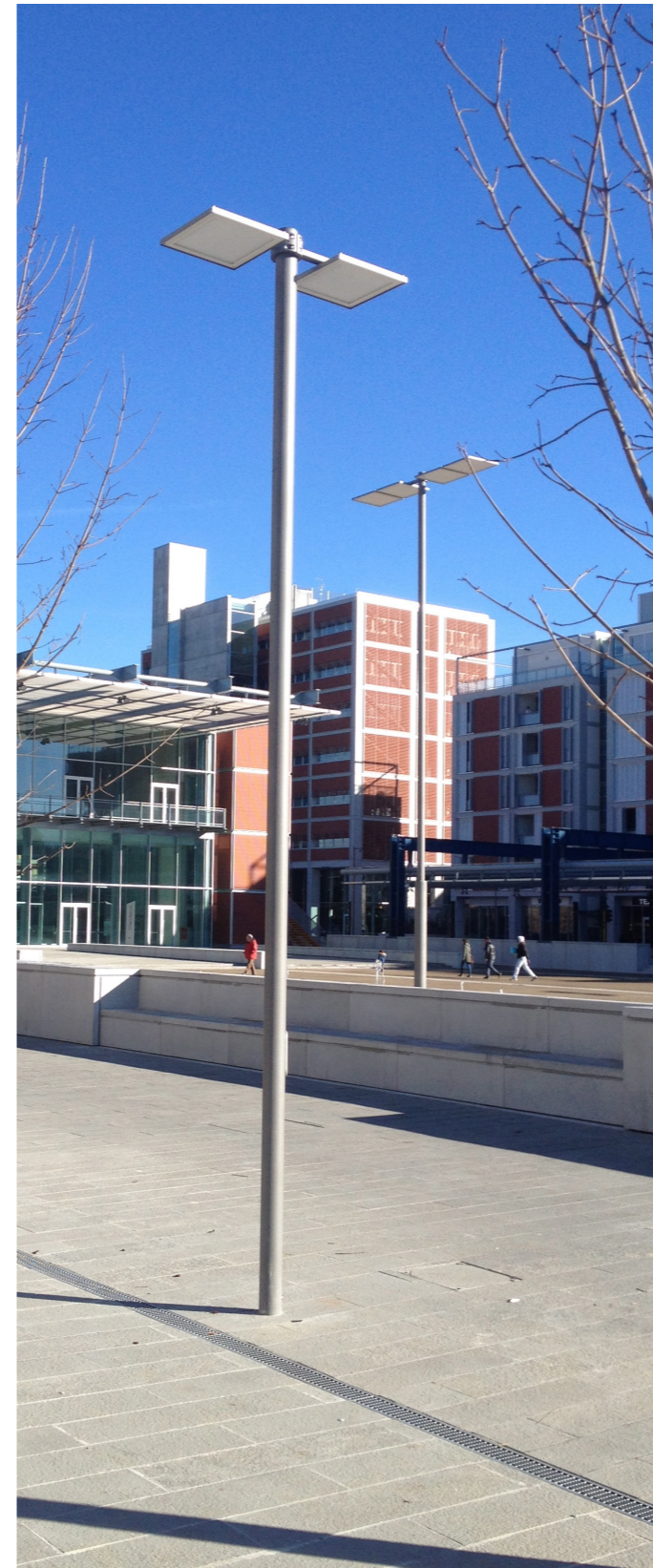
palo h5m con corpo illuminante tipo iGuzzini, modello Ufo
