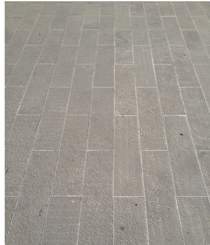
pavimentazione in pietra Serena Extraforte del NCC
