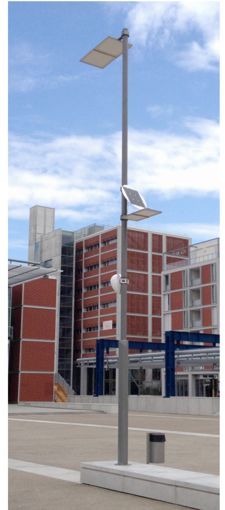
palo h10m con corpo illuminante a doppia altezza
