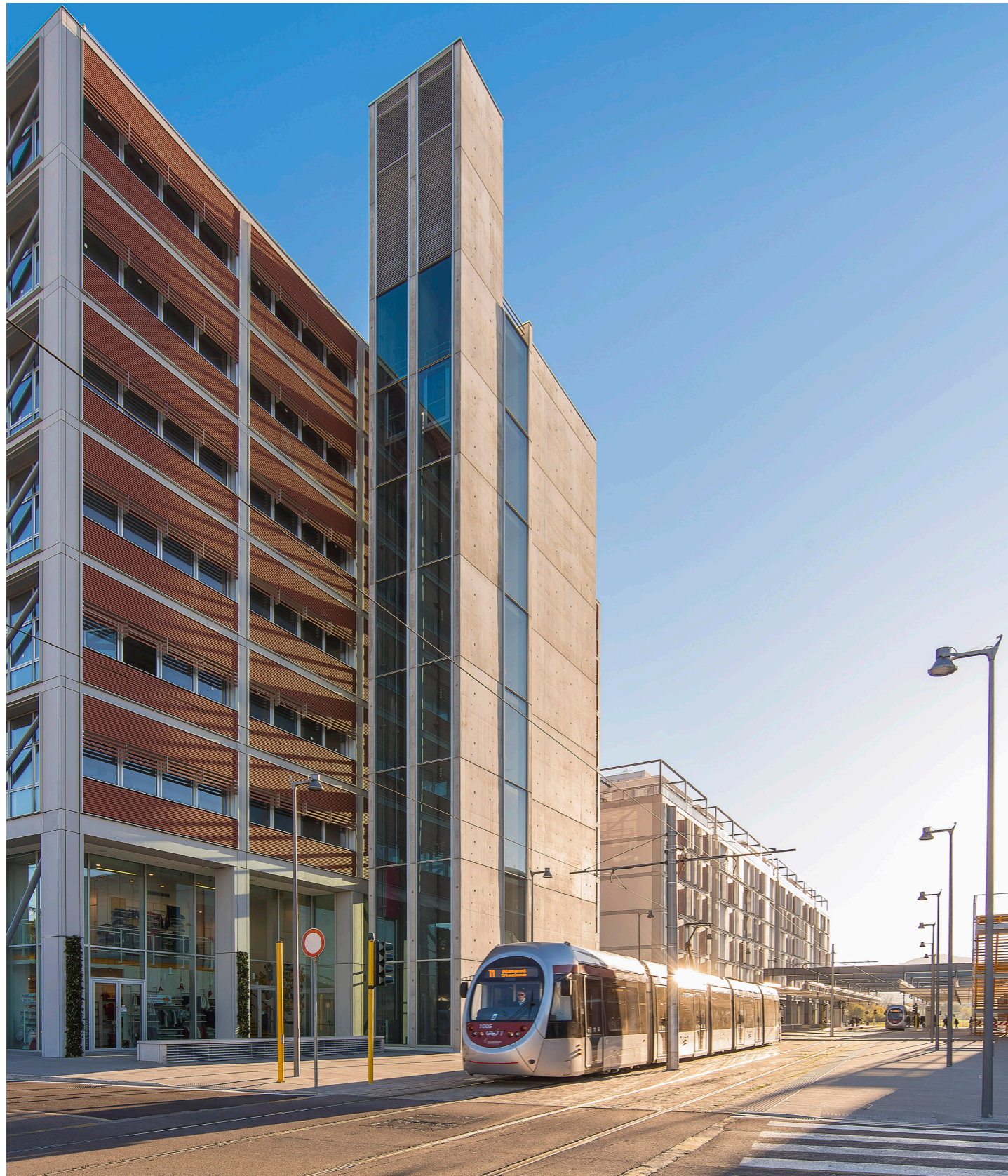
La torre dell'Edificio Direzionale segna l'ingresso al Nuovo Centro Civico
