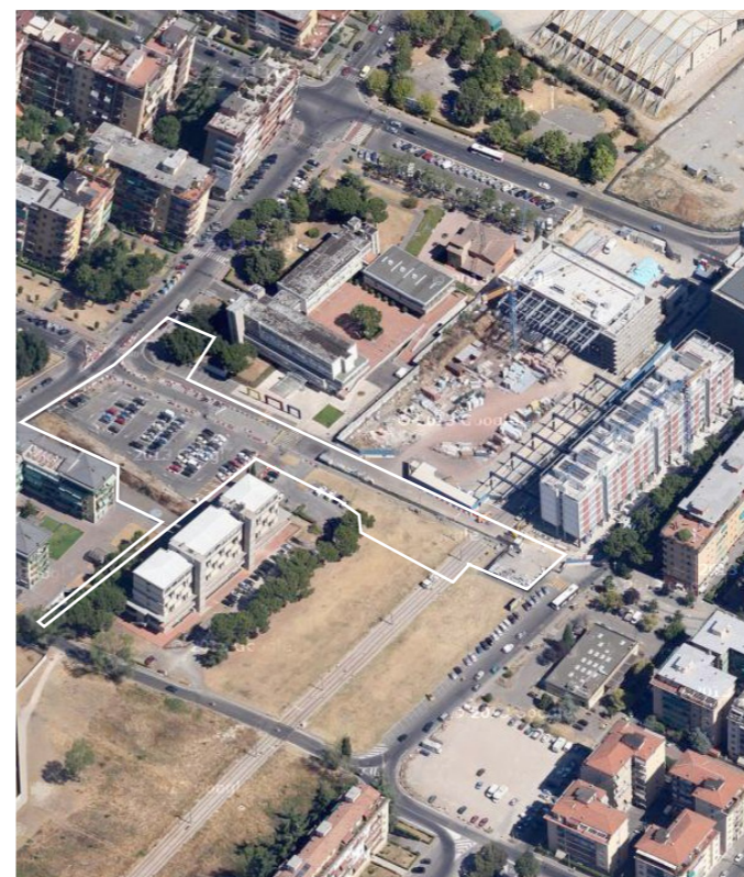
Vista a volo d'uccello dell'area d'intervento da Sud
