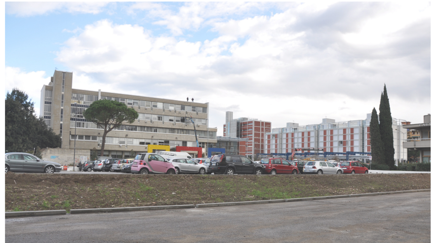
6-Vista del Palazzo Comunale dal Parcheggio, sullo sfondo il Nuovo Centro Civico (Dicembre 2013)
