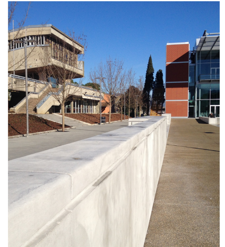
elementi di rivestimento in calcestruzzo prefabbricati
